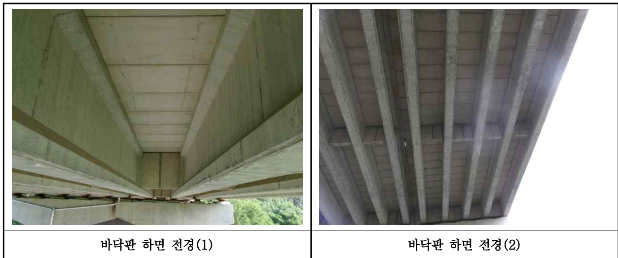
【사진 30.3.2】 바닥판하면 전경
