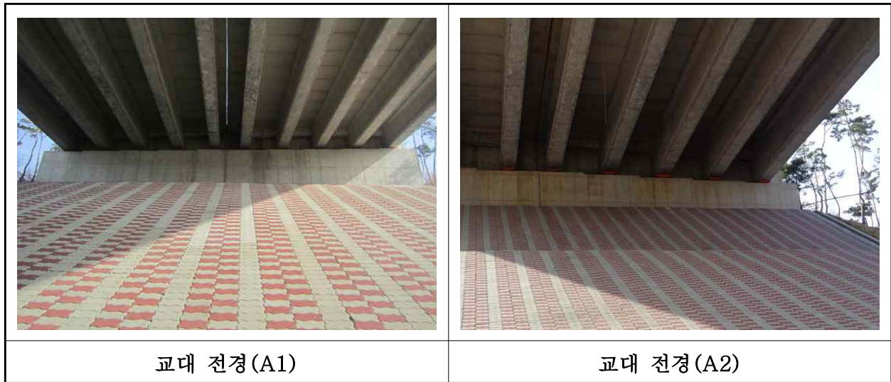
【사진 30.3.33】 교대 전경
