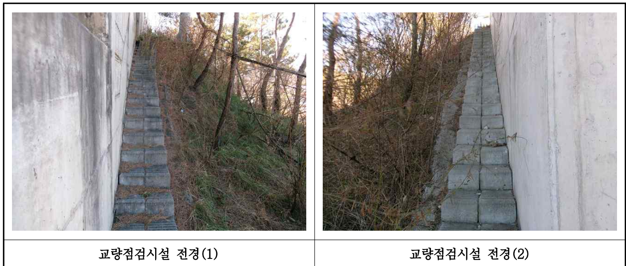
【사진 30.3.25】 교량 점검시설 전경
