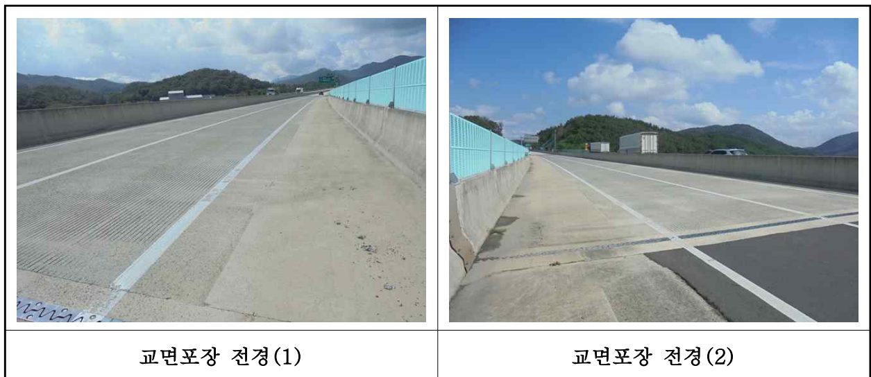
【사진 30.3.44】 교면포장 전경
