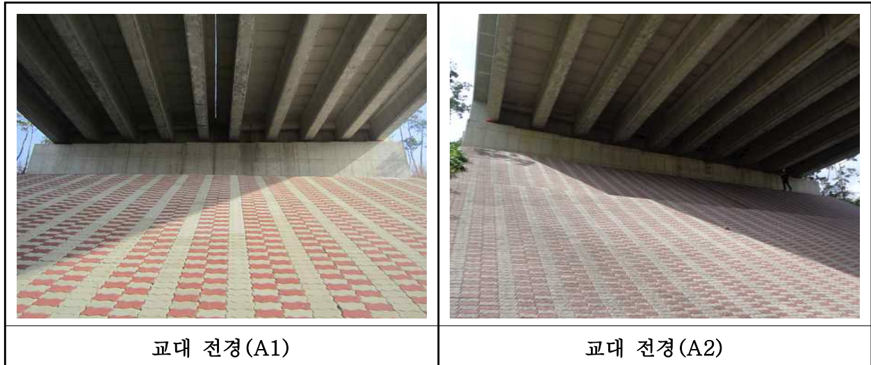
【사진 30.3.8】 교대 전경
