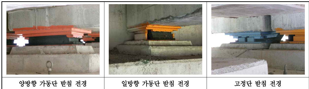
【사진 30.3.37】 교량받침 전경
