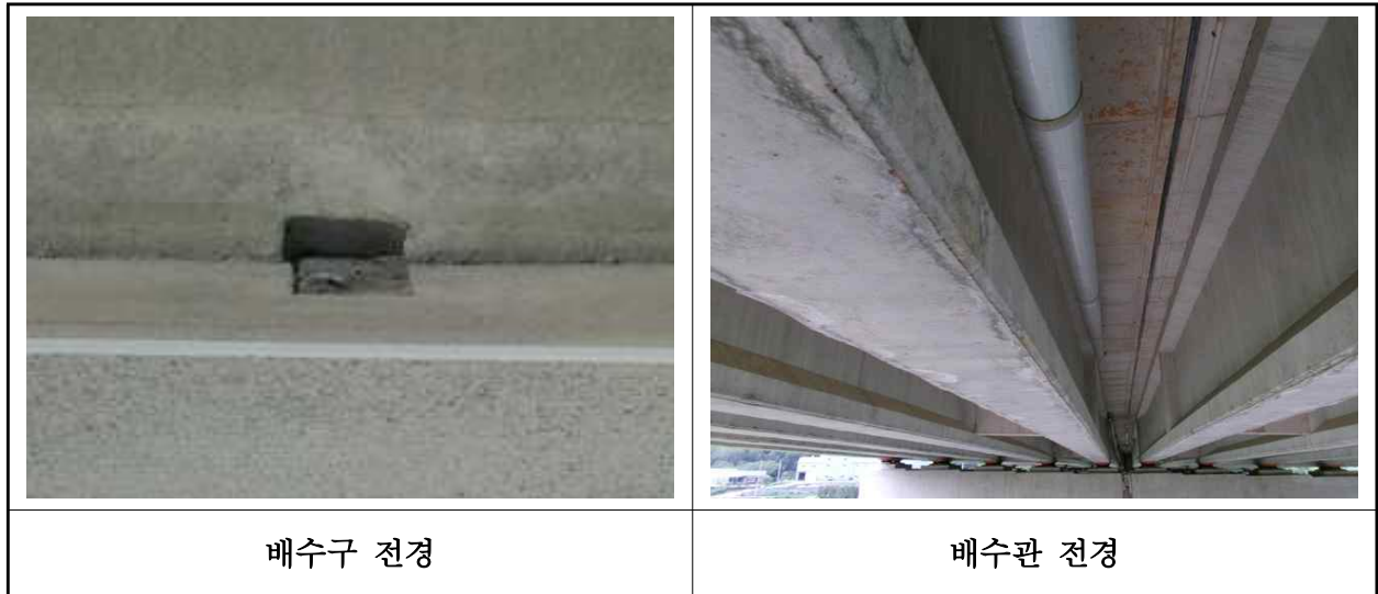
【사진 30.3.21】 배수시설 전경
