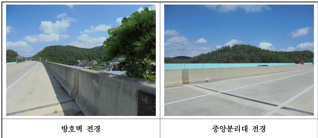
【사진 30.3.23】 방호벽 및 중앙분리대 전경
