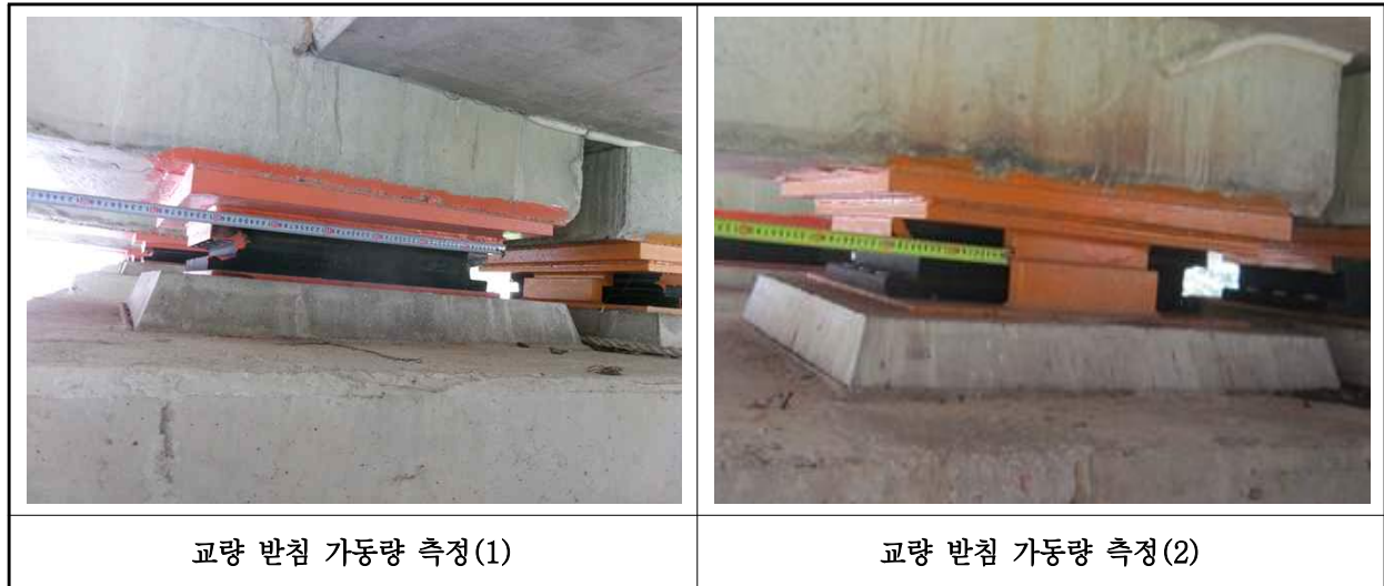
【사진 30.3.40】 교량받침 이동량 상태
