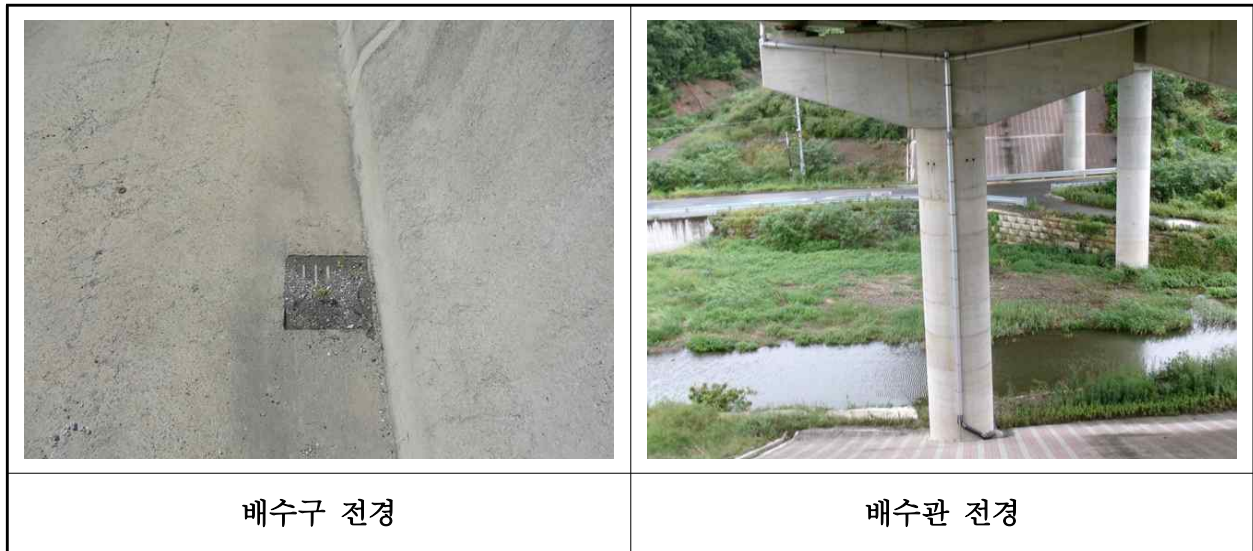
【사진 30.3.46】 배수시설 전경
