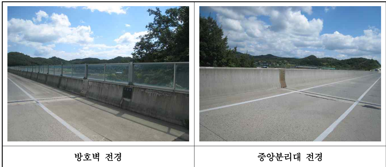
【사진 30.3.48】 방호벽 및 중앙분리대 전경
