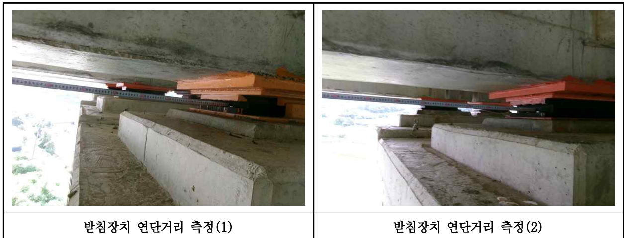
【사진 30.3.14】 교량받침장치 연단거리측정
