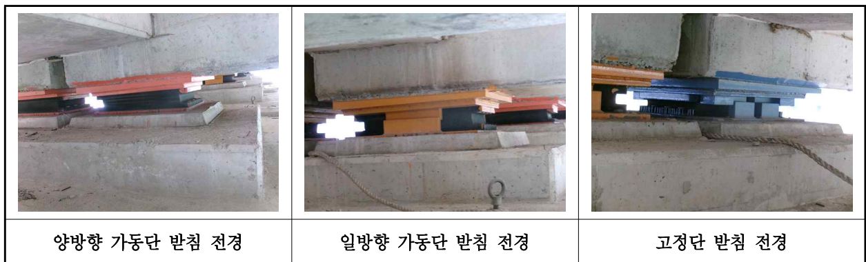
【사진 30.3.12】 교량받침 전경
